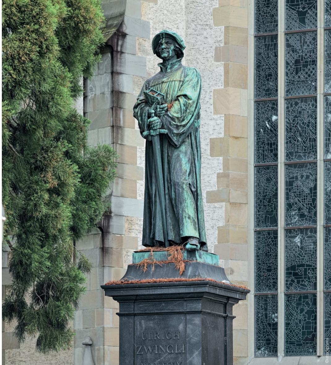
Das Zwingli-Denkmal steht seit 1885 vor der Wasserkirche in Zürich. Unlängst musste es wegen Korrosionsschäden umfassend restauriert werden.
