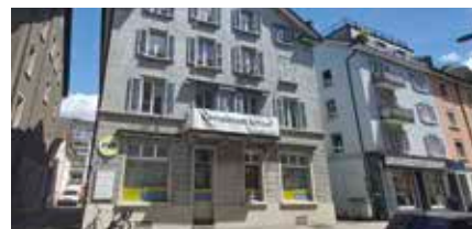
Das SEA Team wird nach der Renovation die Büroräumlichkeiten im Parterre beziehen.
